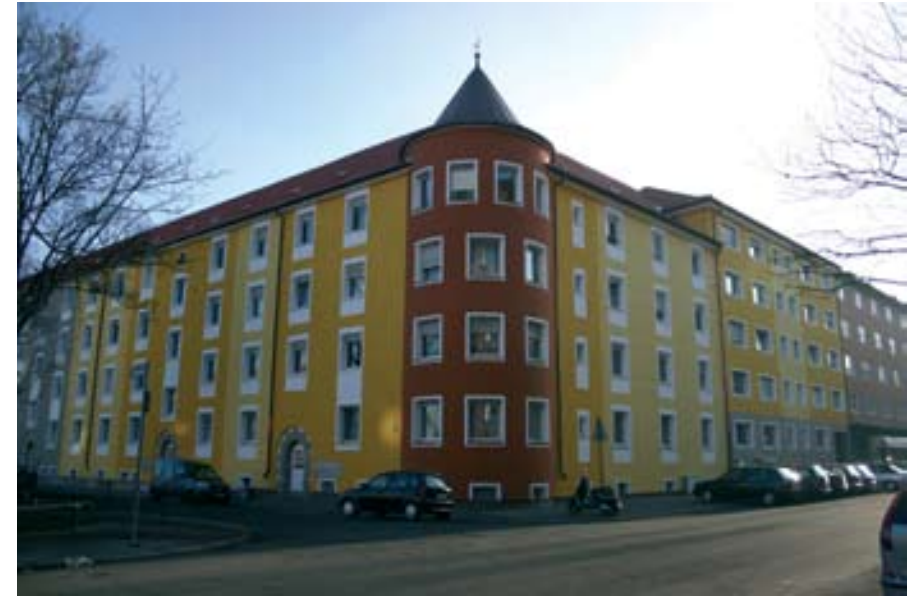
Nach einer gründlichen Sanierung des Altbestandes geben heute bunte Farben den Häusern der Wohnungsgenossenschaft „Sigmund Schuckert“ ein freundliches Ambiente.
