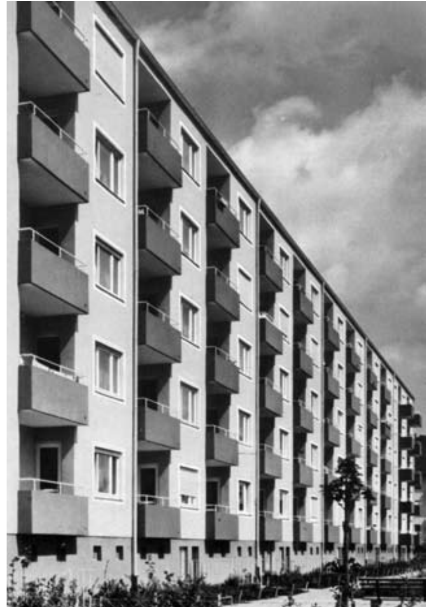
Geschosswohnungsbau in den 1960er Jahren.
