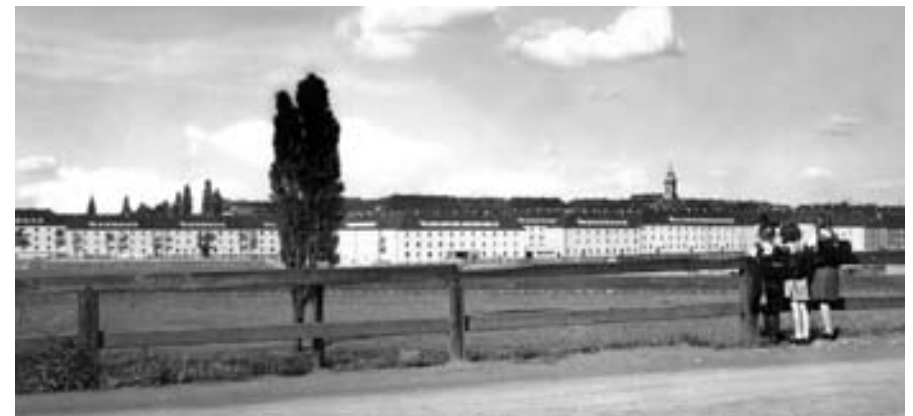
Eine Großsiedlung der wbg Nürnberg. Die Siedlung St. Johannis war kleinbürgerlich geprägt. Durch die geschlossene Wohnanlage hatte sie sogar einen dörflichen Charakter.
