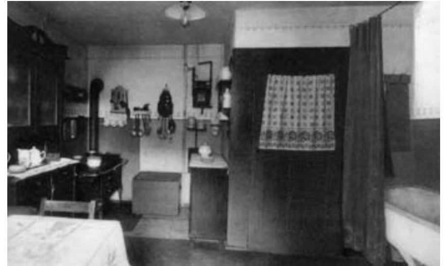
Eine typische Wohnküche in einer Genossenschaftswohnung 1922. Das Zimmer diente als Küche, Wohnzimmer und Badezimmer zugleich. Der Abort befand sich oft auf halber Treppe oder im Hof.
