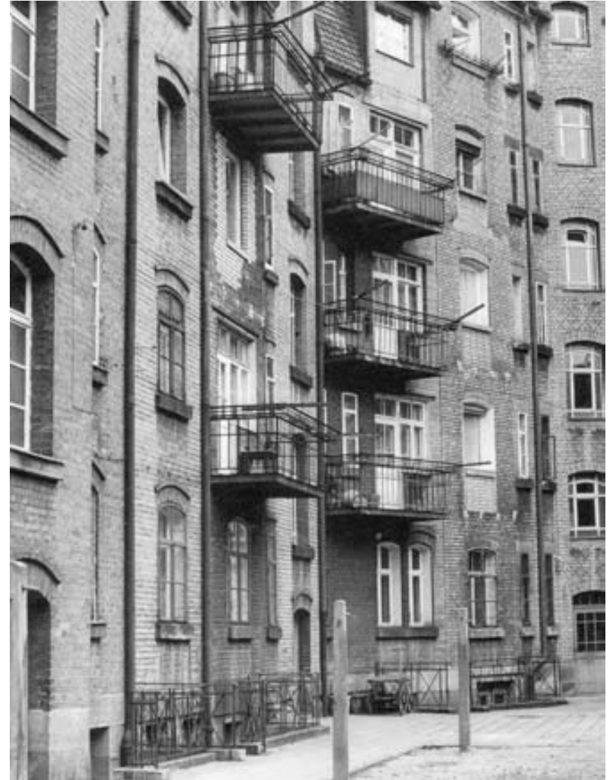
Die Sozialbauten, die in den ersten Jahrzehnten des 20. Jahrhundert errichtet worden waren, waren ab Ende der 1970er Jahre sanierungsbedürftig. Außerdem wurden Umbauten notwendig, um sie an den neuen Wohnungsstandard anzupassen: Bäder, Toiletten, Zentralheizungen und moderne Küchen wurden eingebaut.
